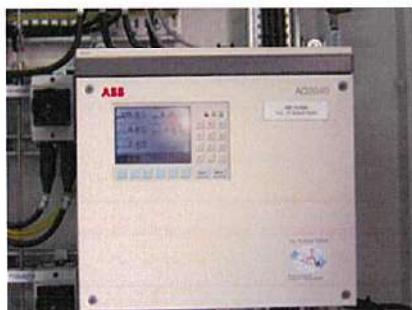
ภาพที่ 2.2- 2 ระบบ CEMs ของ Furnance (F-530)
