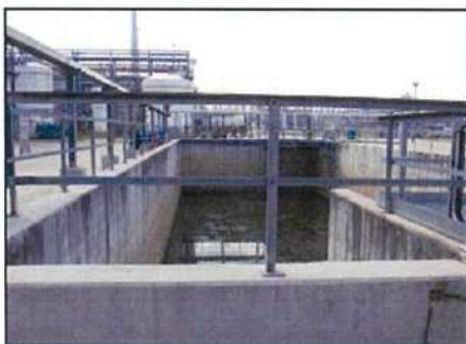
ภาพที่ 2.2- 10 บ่อพักน้ำเสียขนาด 2,000 ลบ.ม.
