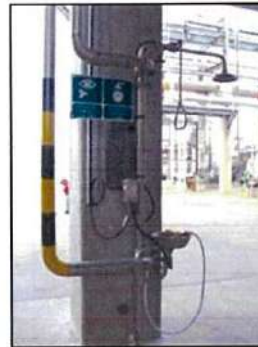
ภาพที่ 2.2- 19 อุปกรณ์ชำระล้างฉุกเฉินในพื้นที่โครงการ (ฝักบัวฉุกเฉินและที่ล้างตาฉุกเฉิน)
