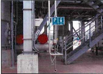
ภาพที่ 2.2- 19 อุปกรณ์ชำระล้างฉุกเฉินในพื้นที่โครงการ (ฝักบัวฉุกเฉินและที่ล้างตาฉุกเฉิน)
