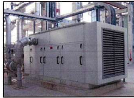
ภาพที่ 2.2- 8 อุปกรณ์ลดเสียงและวัสดุปิดครอบ เครื่องจักรที่เป็นแหล่งกำเนิดเสียง
