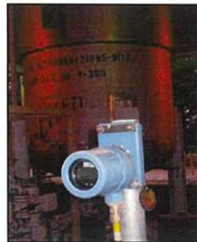
ภาพที่ 2.2- 21 ระบบควบคุมความดันและอุณหภูมิของระบบท่อขนส่ง และถังเก็บสารเคมี
