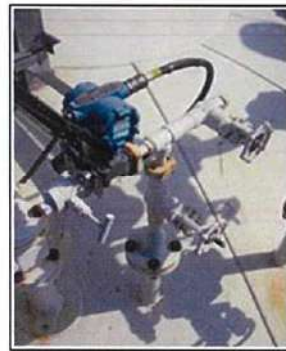
ภาพที่ 2.2- 21 ระบบควบคุมความดันและอุณหภูมิของระบบท่อขนส่ง และถังเก็บสารเคมี
