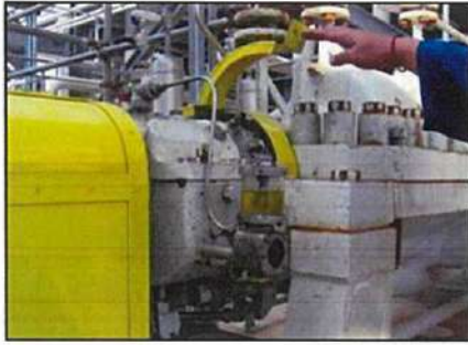
ภาพที่ 2.2- 5 Double Mechanical Seal ที่ใช้กับสารไฮโดรคาร์บอนของอุปกรณ์เครื่องจักรแบบหมุน
