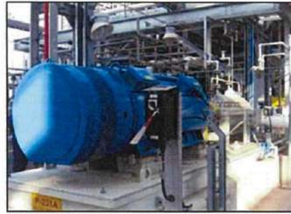
ภาพที่ 2.2- 5 Double Mechanical Seal ที่ใช้กับสารไฮโดรคาร์บอนของอุปกรณ์เครื่องจักรแบบหมุน
